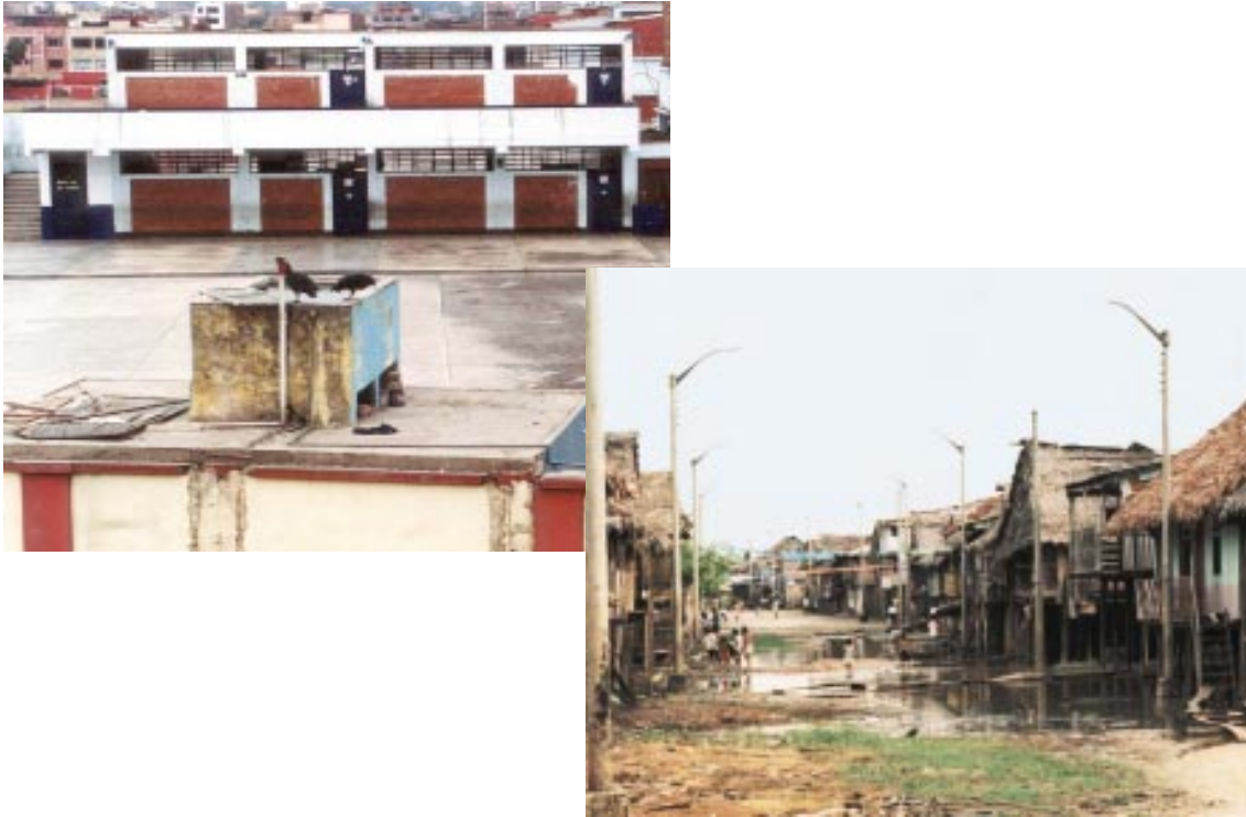
Fig. 77 Tanque alto destapado en Lima (izq.) y empozamiento de agua de lluvia en Belén, Iquitos (der.).
