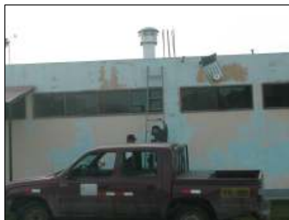
Equipos de monitoreo de la Calidad de Aire Funcionando en la azotea del Hospital Amazónico
