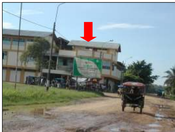
Equipo de monitoreo de la Calidad de Aire Instalado en la azotea del CLAS 07 de junio
