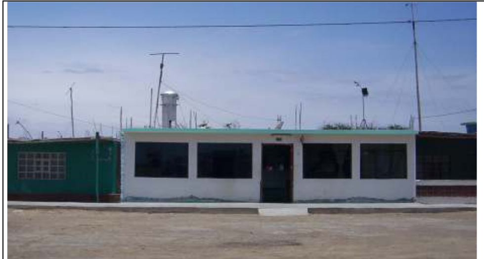
ESTACION E-1 UBICADA EN VIVIENDA DE PUERTO HUARMEY
