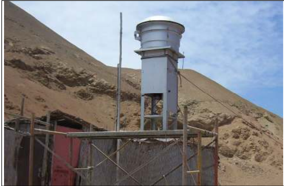
ESTACION E-2 UBICADA EN VIA CENTRAL DE PUERTO GRANDE
