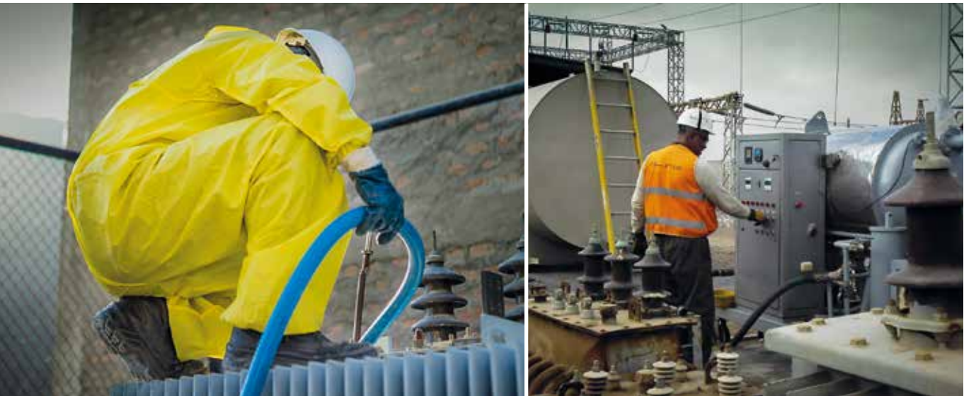
Foto N° 12: Proceso de retrolenado en equipos con PCB
