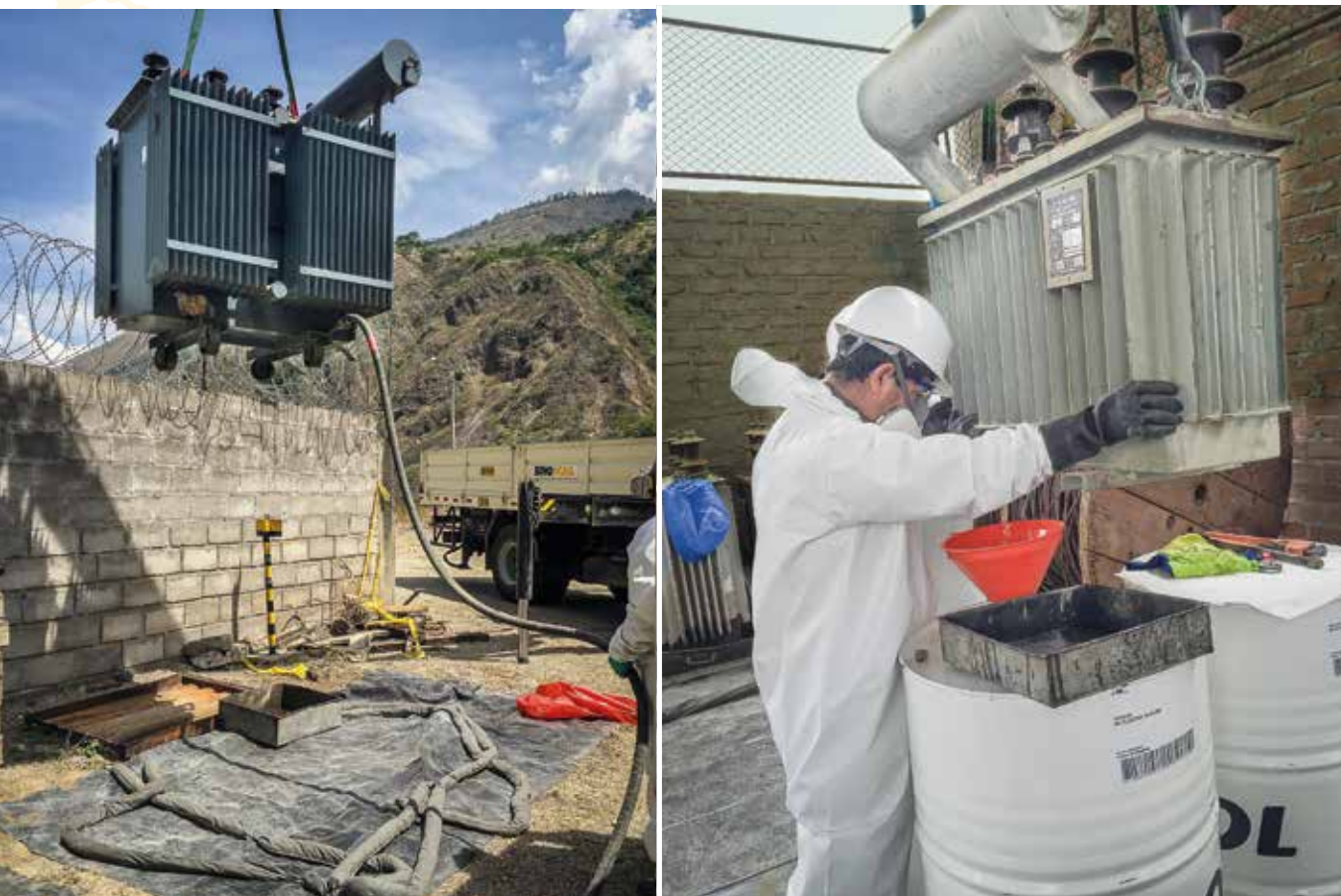
Foto N° 7: Vaciado por gravedad de equipos con PCB
