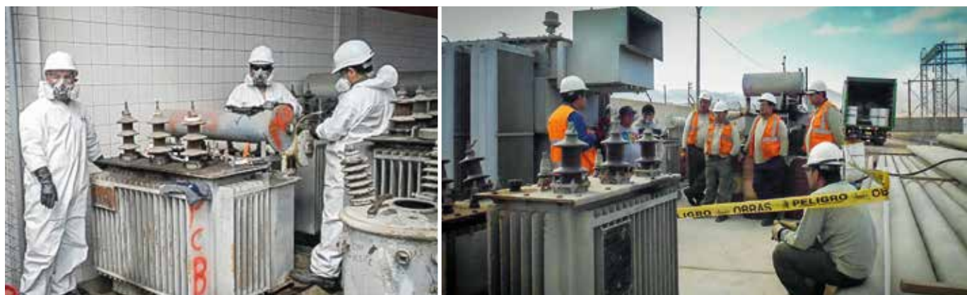
Foto N° 1: Personal técnico recibiendo charlas de capacitación y con equipos de protección personal
